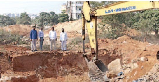
అన్నేశిగూడలో రెండు కోట్ల నిధులతో నిర్మిస్తున్న వెజ్ నాన్‌వెజ్ మార్కెట్టు భవన నిర్మాణ పనులను పరిశీలిస్తున్న చైర్మన్ బి. కొండర్ రెడ్డి తదితరులు.
